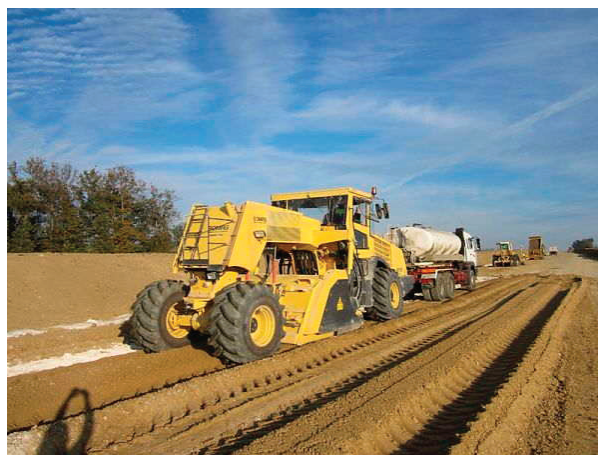
Рис. 5. Ресайклер в работе
