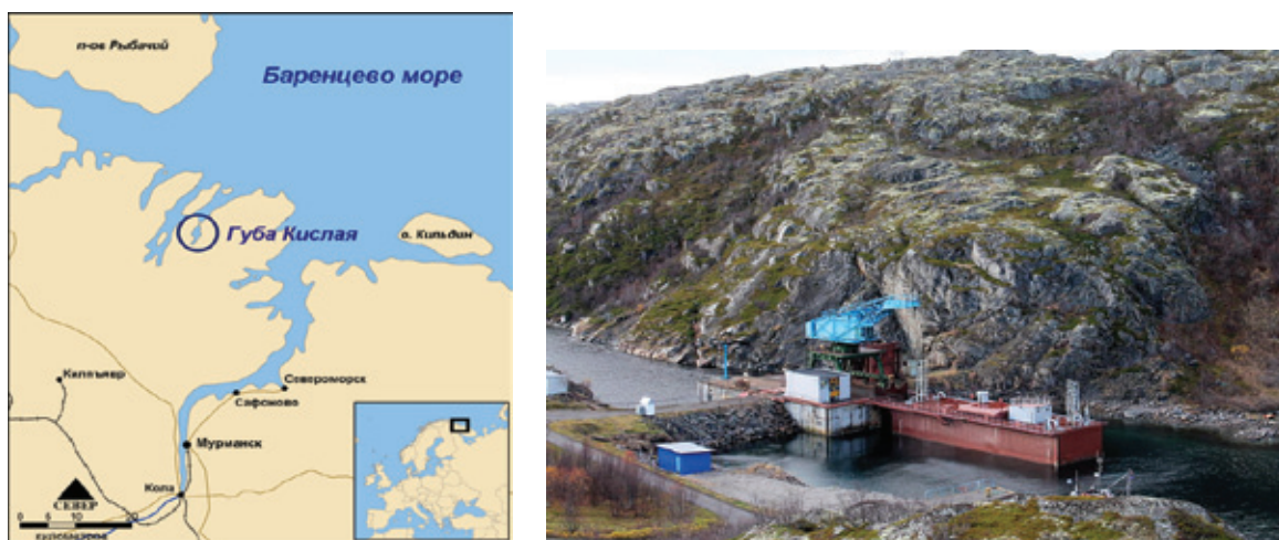
Рис. 6. Экспериментальная приливная электростанция в Кислой губе на побережье Баренцева моря [8]
