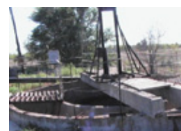
Рис. 2. Горизонтальная песколовка с круговым движением воды
