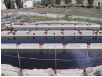
Рис. 3. Двухъярусный первичный отстойник
