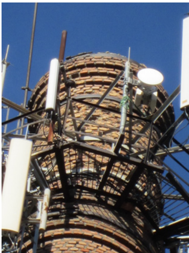
Рис. 1. Кирпичная труба г. Сердобск, Пензенская область
