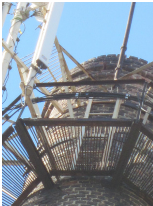
Рис. 2. Кирпичная труба г. Сердобск, Пензенская область
