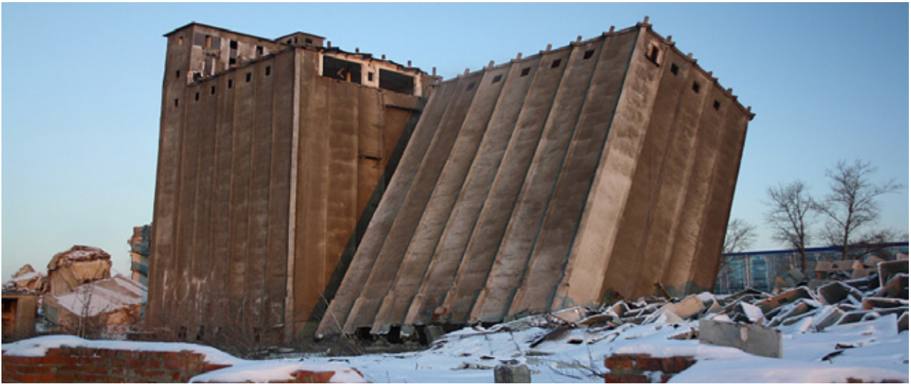
Рис. 2. Обрушение в здании элеватора в г. Калуге
