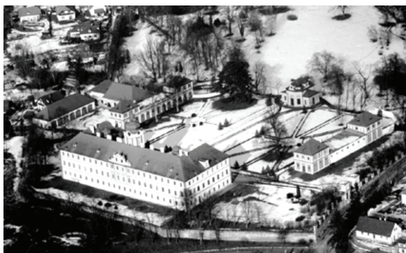
Рис. 12. Вид с воздуха на территорию замка ( http://www.panoramio.com/photo/18482283 )
