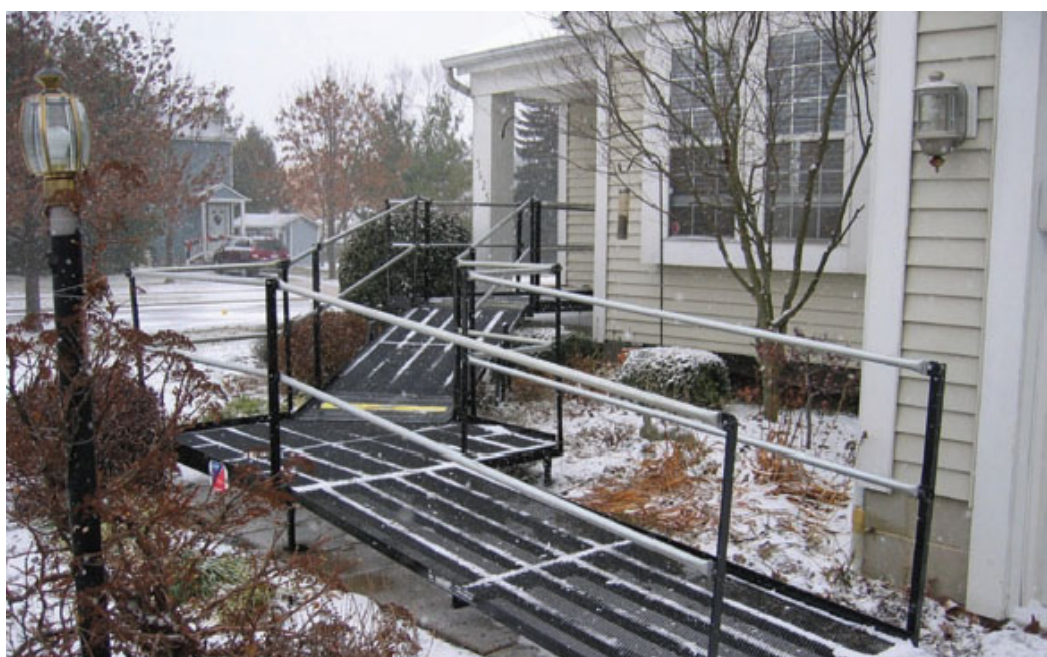
Рис. 4. Крыльцо дома, оборудованное пандусом
