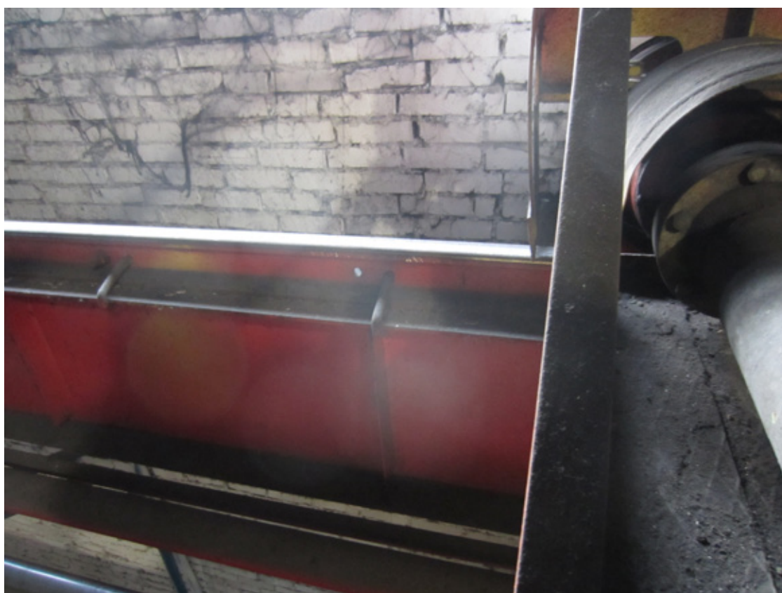
Рис. 3. Наличие недостающих болтов крепления планок скрепления рельсов между собой
