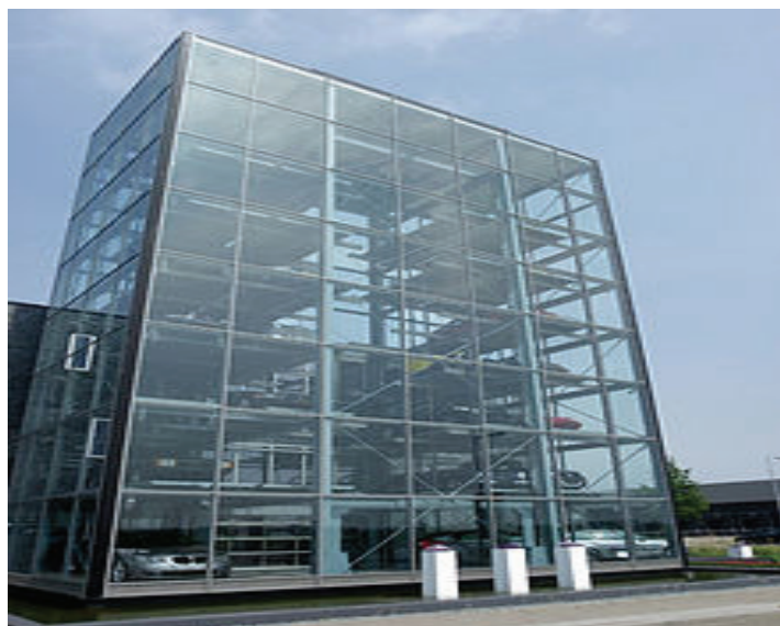
Рис. 1. Многоярусный автоматический паркинг тип «Тауэр»
