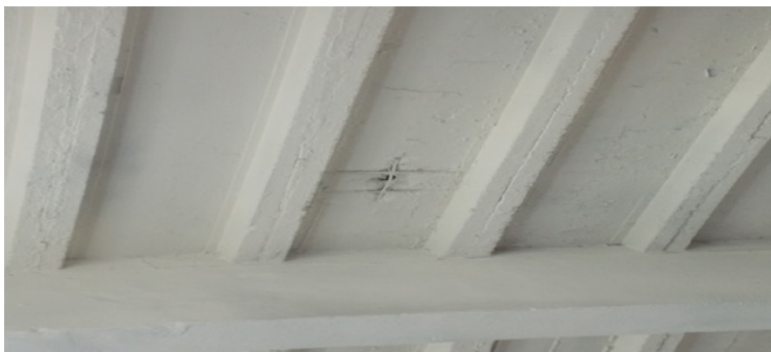
Рис. 5. Отслоение защитного слоя бетона с оголением арматуры
