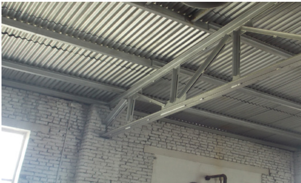
Рис. 4. Стальная ферма покрытия из парных уголков
