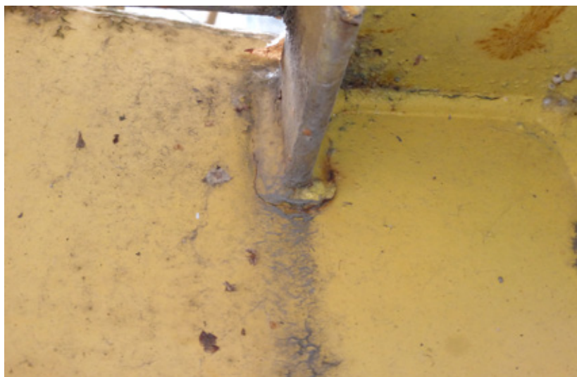
Рис. 2. Трещины в металлоконструкциях башенного крана (Liebher)
