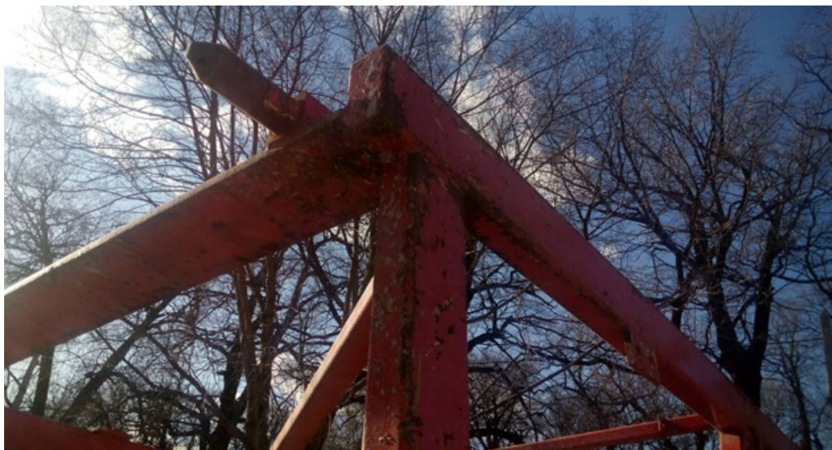
Рис. 3. Коррозия конструкций башенного крана (Terex)
