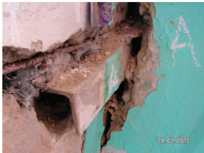
Рис. 4. Закладная деталь сместилась из проектного положения
