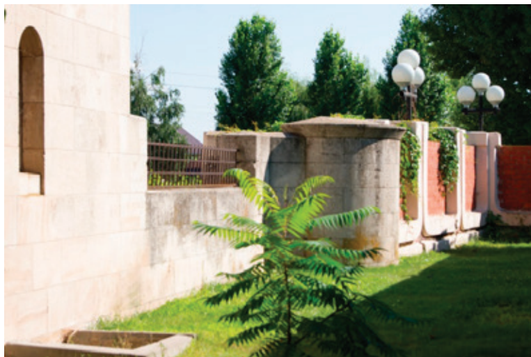
Рис. 4. Часть «шехтелевской» ограды с северной стороны., которая примыкает к просвирне, как один пролет с металлической решеткой, а к нему примыкает авторская поворотная овальная в плане тумба
