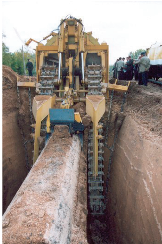
Рис. 1. Капитальный ремонт газопровода
