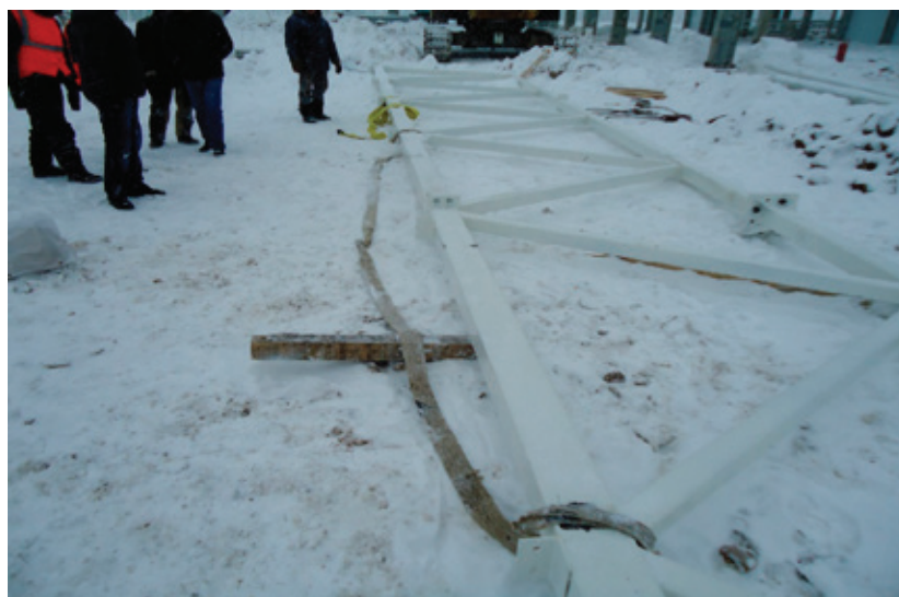
Рис. 4. Схема распределения нагрузок на ветви стропа, строповка фермы: I — рекомендуемая зона захвата груза;
