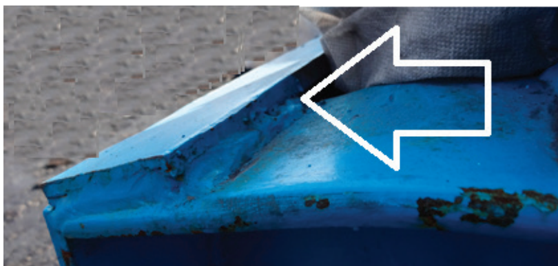
Рис. 2. Дефект сварного шва
