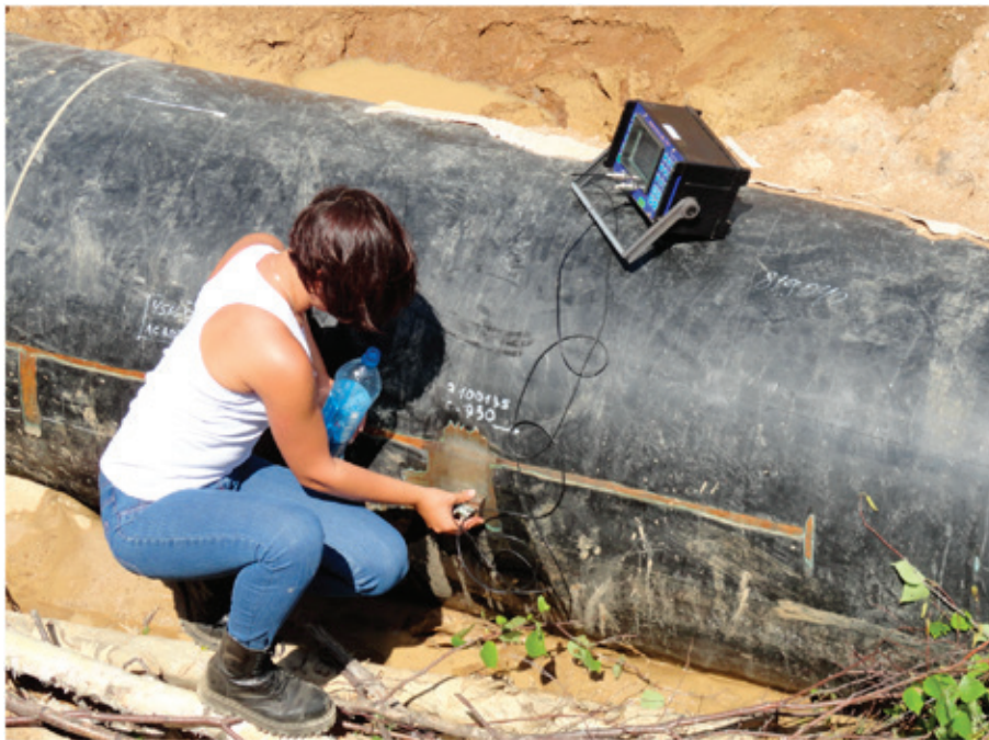
Рис. 3. Исследование дефекта риска на поверхности стальной трубы с помощью электронной аппаратуры
