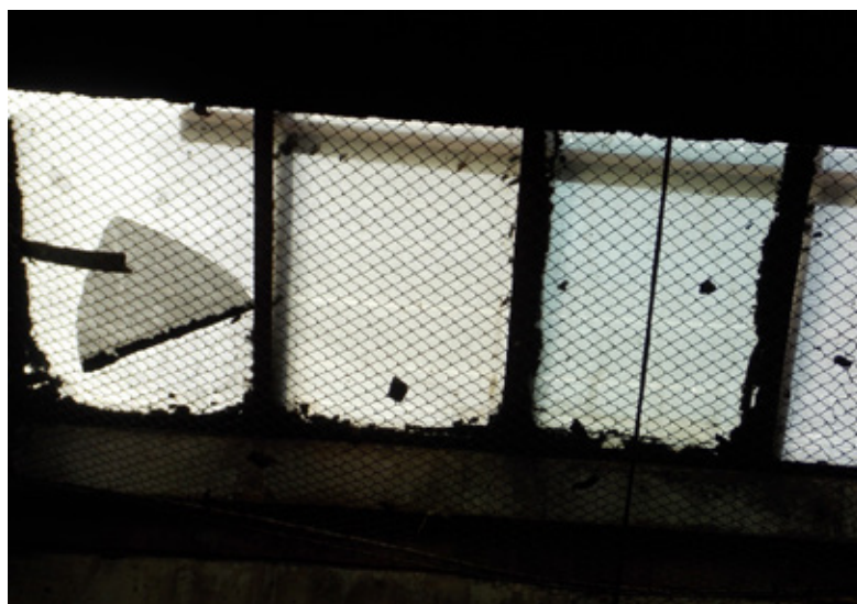
Рис. 7. На защитных сетках светоаэрационных фонарей битое стекло (Категория В)
