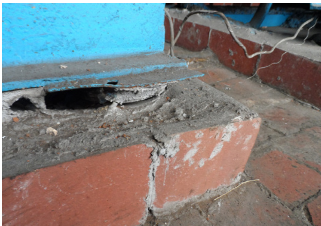
Рис. 8. Виброизоляторы залиты раствором бетона по уровень рамы (основания)
