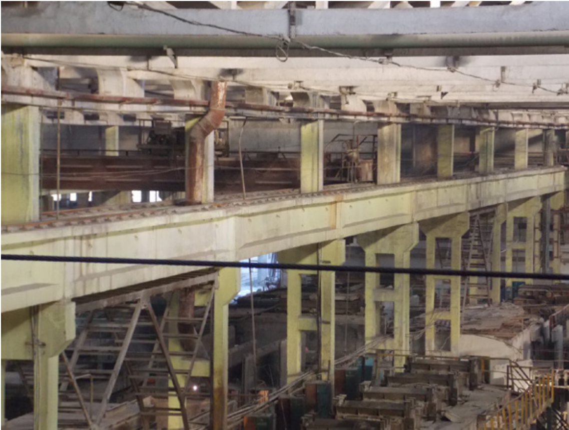
Рис. 1. Общий вид подкрановых балок
