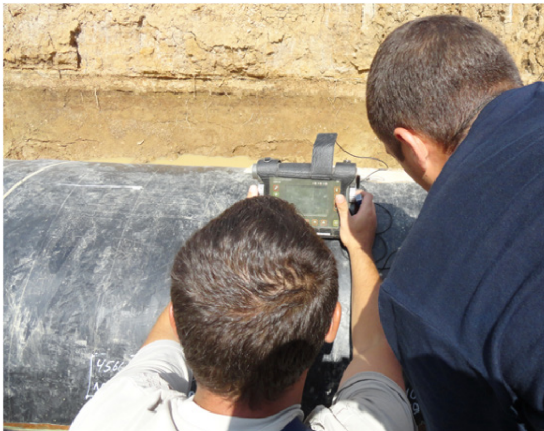
Рис. 3. Исследование дефекта риска на поверхности стальной трубы с помощью электронной аппаратуры
