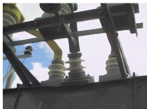
Рис. 4. Тепловизионное обследование ввода 10 кВ трансформатора № 1 ПС 110/10 кВ «0...»
