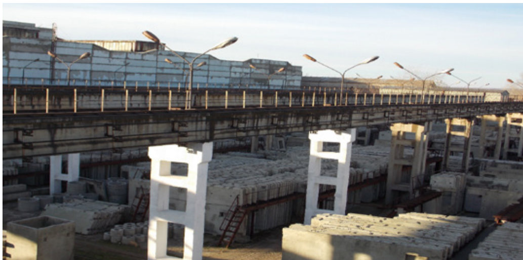
Рис. 4. Общий вид подкрановых балок
