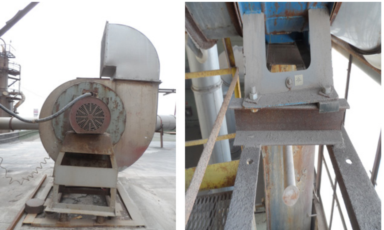
Рис. 5. Крен рамы вентилятора
