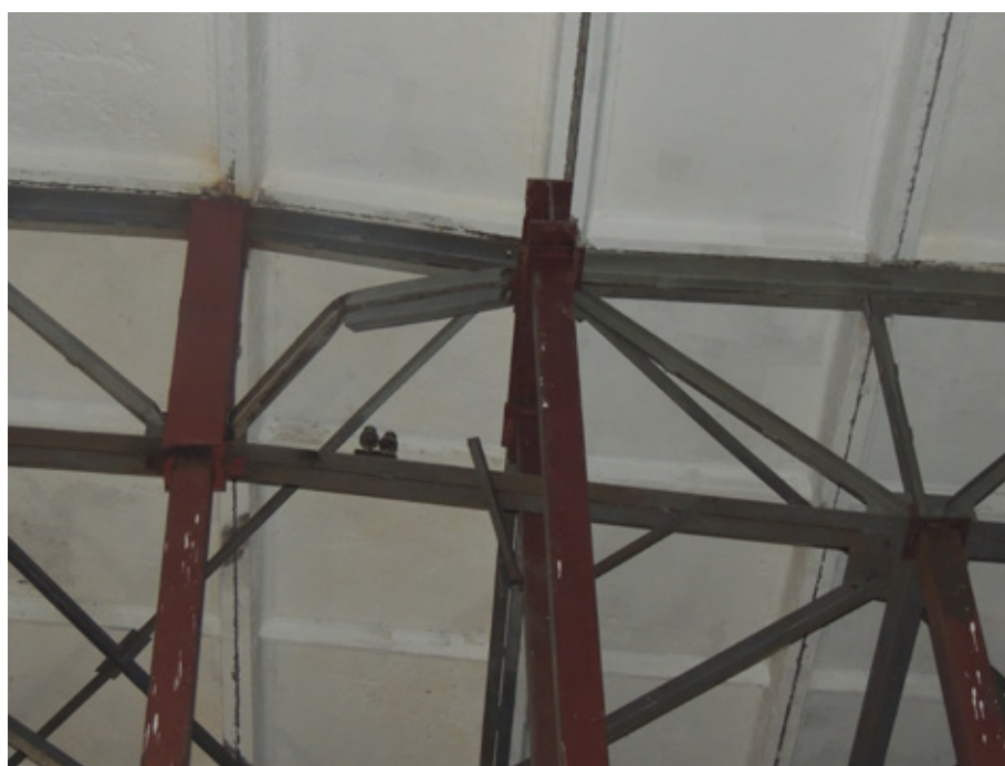
Рис. 2. Общий вид усиленных металлических ферм
