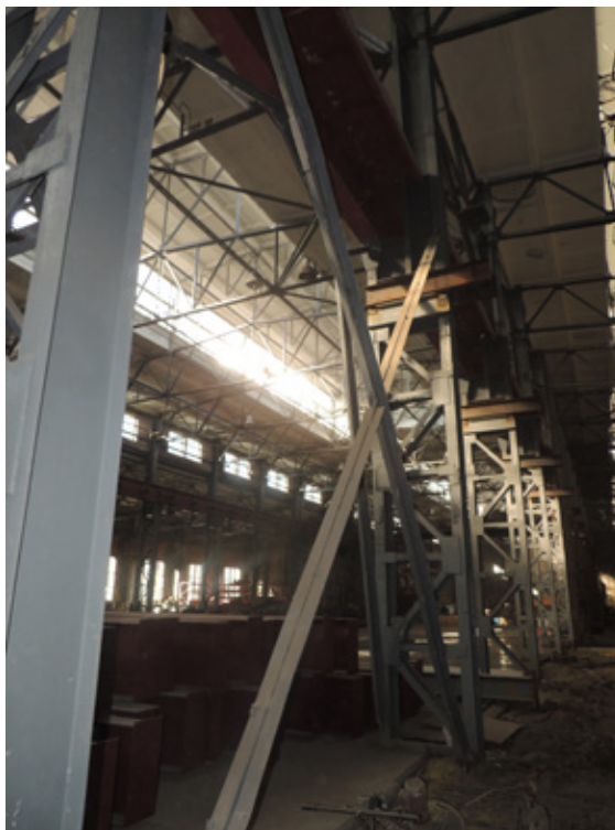
Рис. 1. Общий вид несущих металлических колонн
