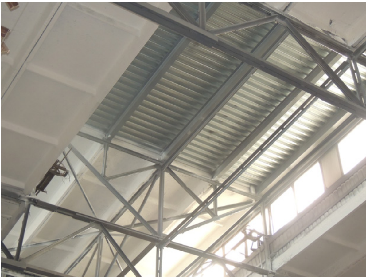
Рис. 3. Общий вид заменённых железобетонных плит покрытия
