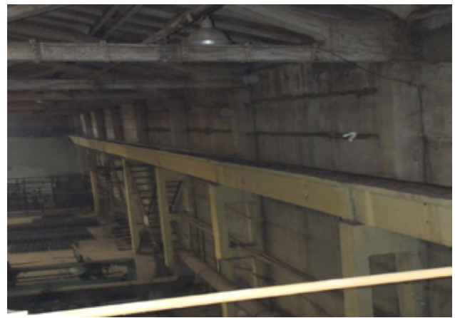
Рис. 10 Общий вид подкрановых балок
