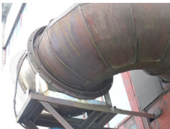
Рис. 11. Деформация воздуховода
