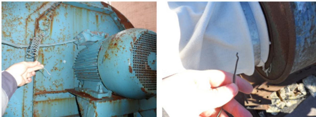
Рис. 9. Обрыв связи контура заземления
