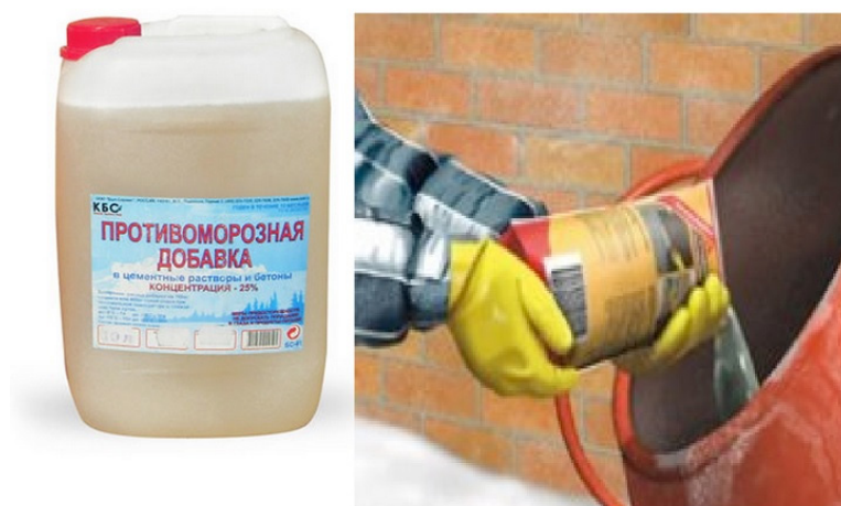
Рис. 4. Добавление в бетон противоморозной добавки
