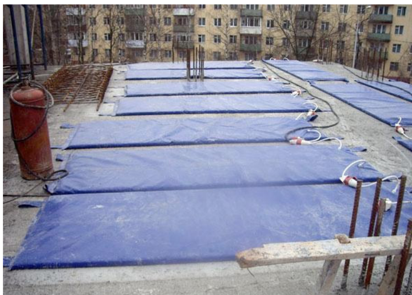
Рис. 9. Прогрев бетона термоматами
