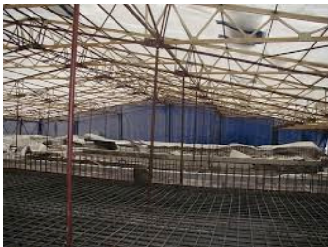
Рис. 3. Выдерживание бетона в тепляке
