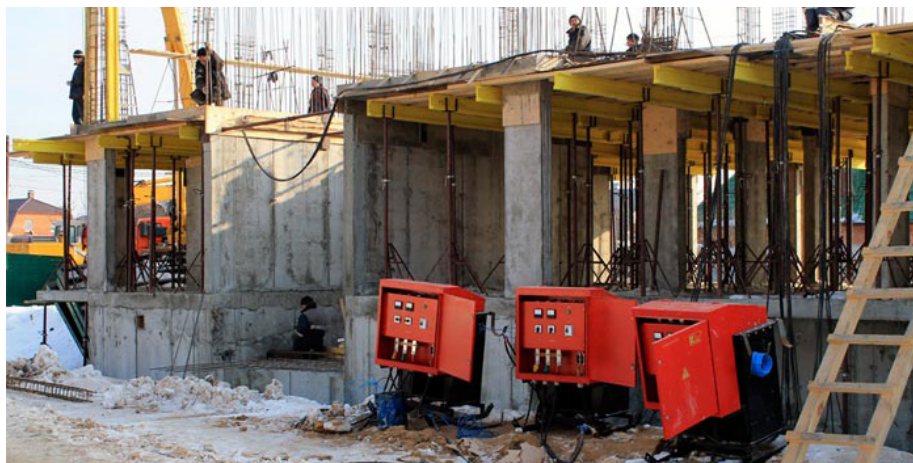
Рис. 5. Прогрев бетона трансформатором
