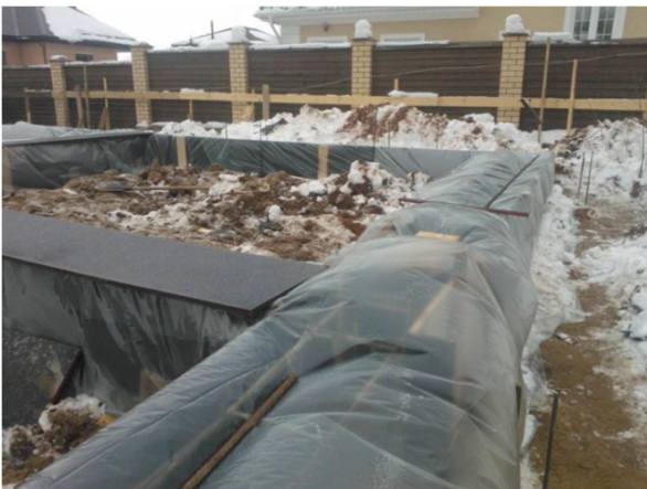
Рис. 12. Бетонирование методом «Термоса»
