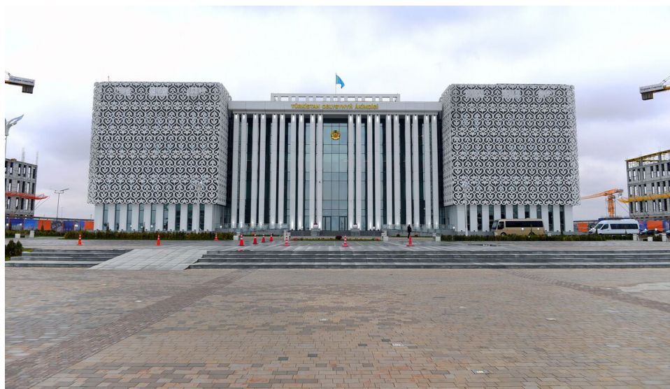
Рис. 5. Здание акимата Туркестанской области
