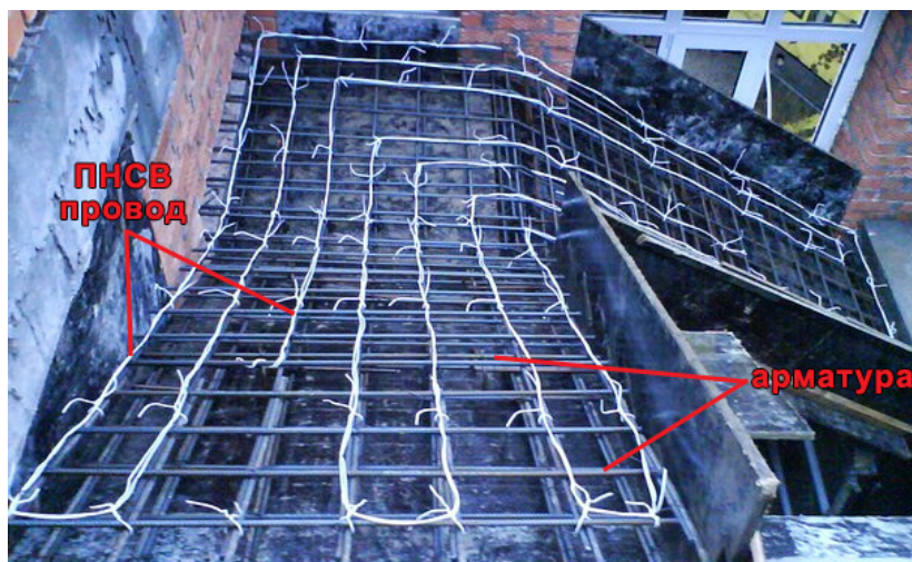
Рис. 6. Монтаж ПНСВ-провода
