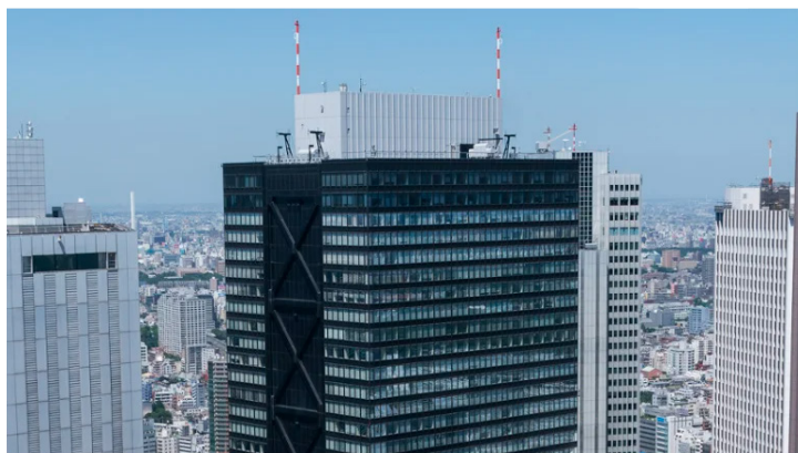
Рис. 2. 300-тонные маятники на крыше здания Синдзюку Мицуи
