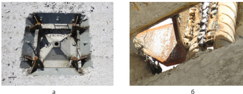
Рис. 2. Качество выполнения монтажного стыка «плита-колонна» сборно-монолитного безригельного каркаса «КУБ»: а — вид на плиту сверху; б — то же, снизу
