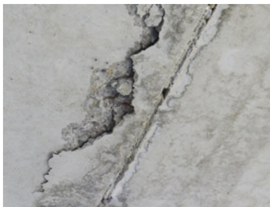
Рис. 4. Трещинообразование в стыке панелей перекрытия сборно-монолитного безригельного каркаса «КУБ»
