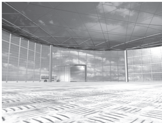
Рис. 1. Внутренний интерьер многопролетного мембранно-пневматического сооружения
