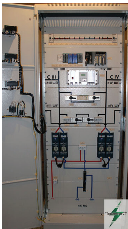
Рис. 5. Панель ввода с разъединителями и встроенными предохранителями
