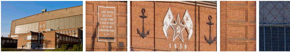
Рис. 3. Декоративная кирпичная кладка и элементы оформления фасадов производственных корпусов, эллинг А. Фото 2000-х гг. Музей АО «ПО Севмаш»
