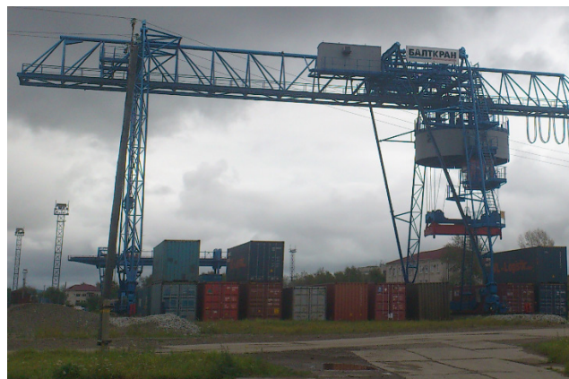
Рис. 4. Один из мостовых кранов, на котором производилось тестирование прототипа системы сбора данных
