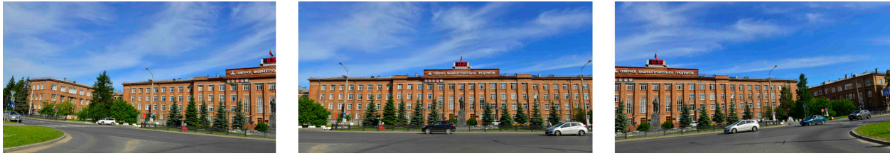
Рис. 1. Здания предзаводской площадки и заводоуправления, построенные по проекту архитекторов братьев Весниных. Фото 2000-х гг. Музей АО «ПО Севмаш»
