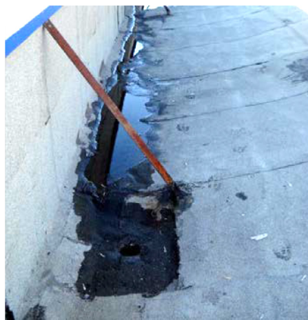
Рис. 3. Внутренний организованный водосток
