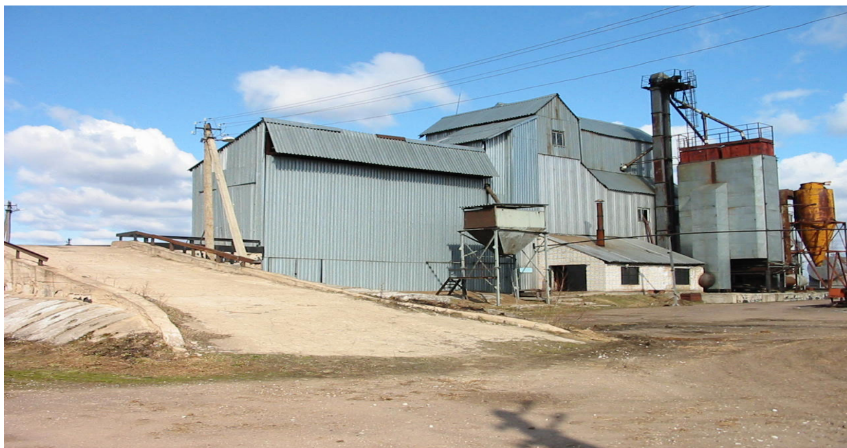
Рис. 2. Комплекс послеуборочной обработки семян зерновых культур на базе шахтной сушилки С-20 в ЗАО «Скреблово» Ленинградской области
