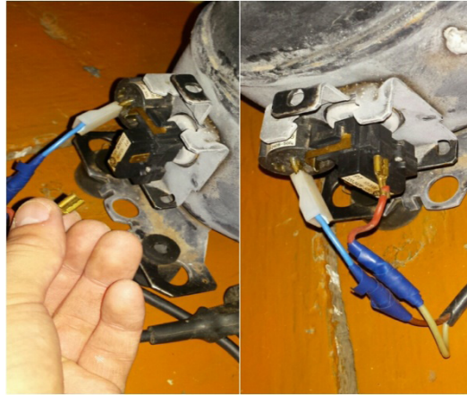
Рис. 2. Подключаем к клемме любой электрический провод
