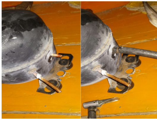
Рис. 3. В задней части компрессора вставляем шланг
