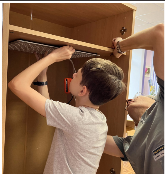
Установка светодиодных светильников
