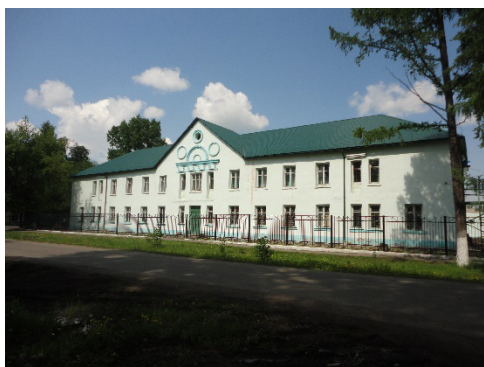
Рис. 3. Фотография фасада вспомогательного корпуса
