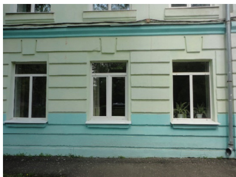
Рис. 7. Фотография части фасада. Русты и замковые камни
