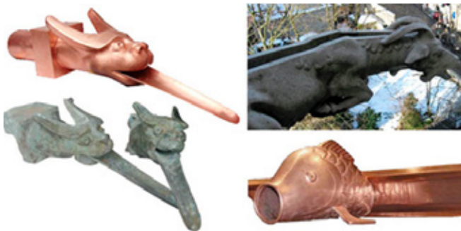
Fig. 7. Gargouilles de la basilique du Sacré-Coeur (Paris, France); leur rôle d'éléments servant à évacuer l'eau pluviale est évident
