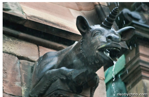
Fig. 5. L'eau se déversant par la gueule d'une Gargouille
